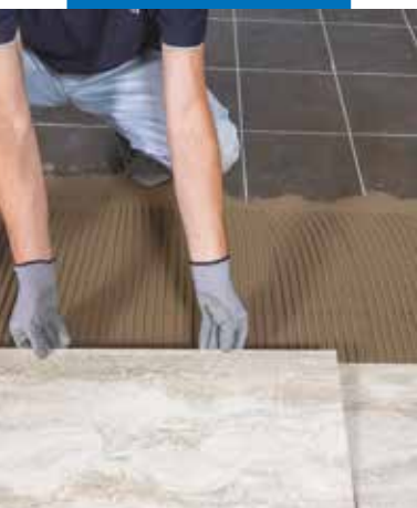
Lepení dlažby s efektem dřeva na stávající dlažbu
