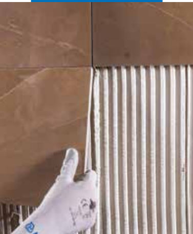
Instalace keramického obkladu
