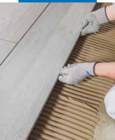
Lepení dlažby s efektem dřeva na podklad ošetřený hydroizolací Mapelastic
