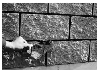
5.–6. Zdění a spárování probíhá v jedné operaci. Povrch spár se uzavře uhlazením spárovacím hladítkem nebo upraveným dřevěným kolíkem.
