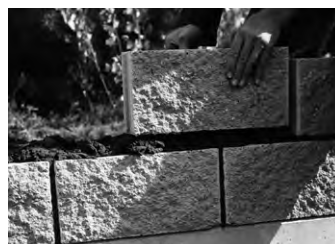
3. Malta vytlačovaná ze spár neodpadává a po seříznutí se dá znovu použít.
