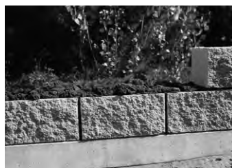
2. Vysoká vláčnost a přilnavost malty k tvárnici umožňuje řádné a celoplošné vyplnění spár.
