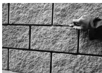
5.–6. Zdění a spárování probíhá v jedné operaci. Povrch spár se uzavře uhlazením spárovacím hladítkem nebo upraveným dřevěným kolíkem.
