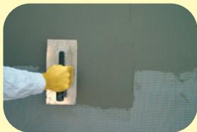
Pokud se vytváří základní vrstva, vkládá se skleněná síťovina do předem nanášené vrstvy stěrkové hmoty a vtlačí se dovnitř zahlazením nerezovým hladítkem směrem od středu ke krajům. Skleněná síťovina je v 1/3 tloušťky základní vrstvy od vrchu.
