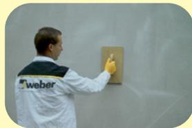
Nanesená hmota se uhladí nerezovým hladítkem. Následující den je možno místní nerovnosti srovnat brusným hladítkem. Krycí vrstva skleněné síťoviny je cca. 1 mm ve spojích 0,5 mm.
