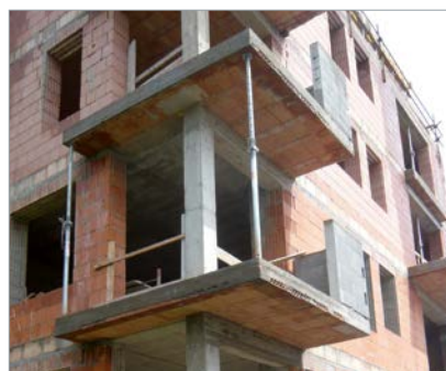
rohový balkón s přidanou výztuží
