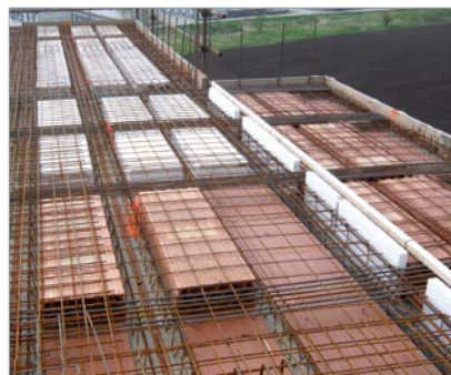
přerušení tepelného mostu mezi balkónem a stropem
